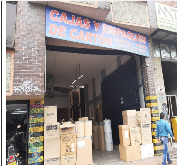
Foto No. 1. Fachada del predio
